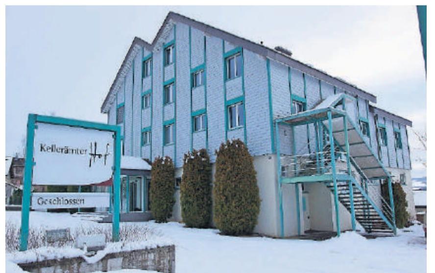
Anstelle des «Kellerämter Hof» entstehen zwei Mehrfamilienhäuser. DOMINIC KOBELT
